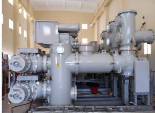
HTPP GIS 110kV đã thi công lắp đặt
